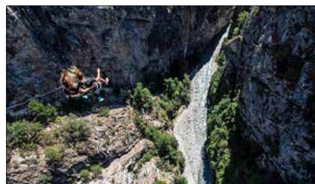
Le pont de Niouc, un des ponts suspendus les plus hauts d'Europe, est situé dans le val d'Anniviers. Il propose des sauts à l'élastique. PHOTOS ANTOINE VULLIOUD
